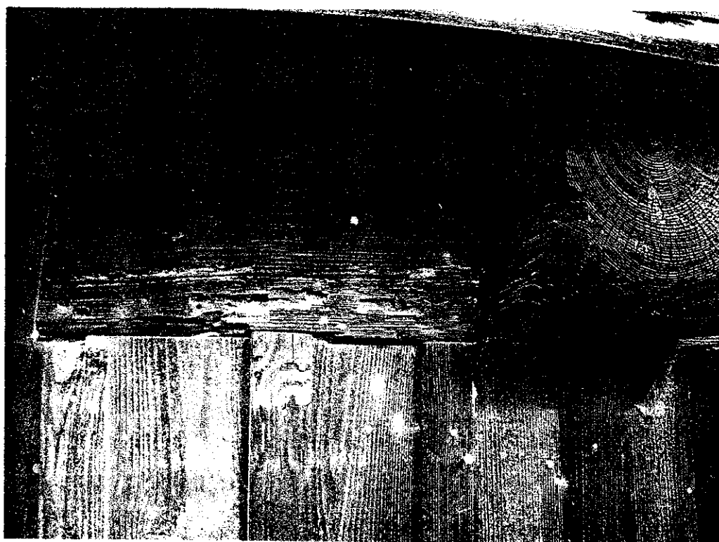
Fot. 16 - ślady żerowania spuszczela pospolitego w konstrukcji i szalunku kruchty południowej
